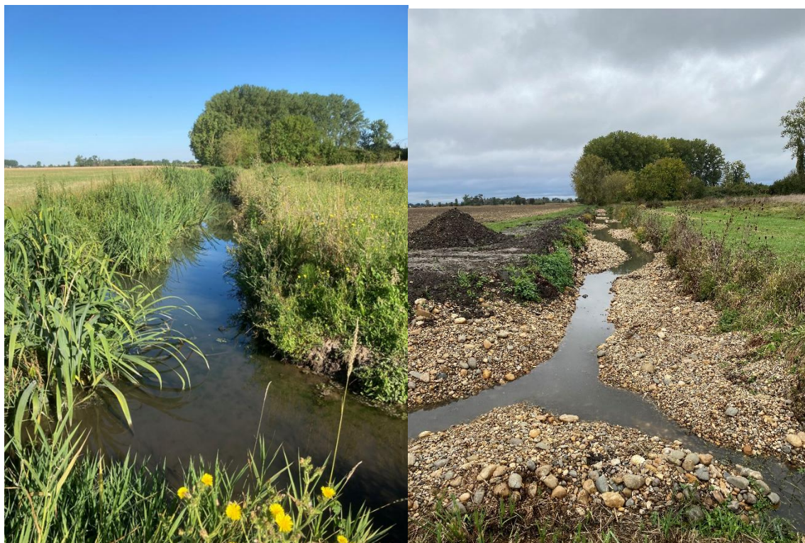
Photo avant travaux (à gauche) et photo après travaux (à droite) sur le site du Vigneron
