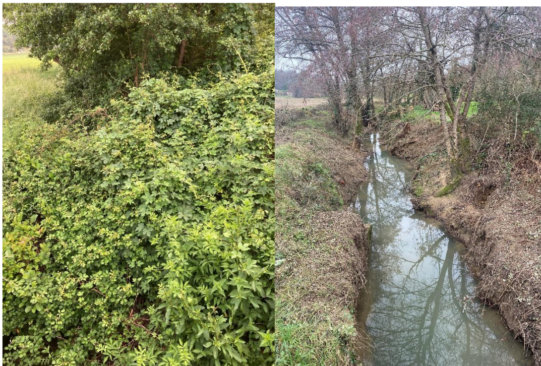
Photo avant travaux (à gauche) et photo après travaux (à droite) sur le site du Loup
